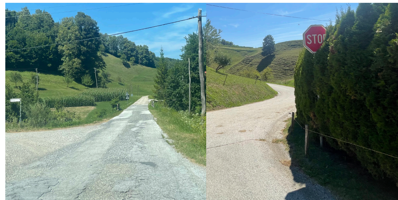
Slika 21 in 22: Dotrajano cestišče in nevarna zasaditev grmovnic in drevesnic v varovalnem pasu ceste in v preglednem polju vozila na glavno prometno smer. Čiščenje obcestnih preglednih berm in zagotavljanje preglednosti je del aktivnega vzdrževanja lokalnih cest.
